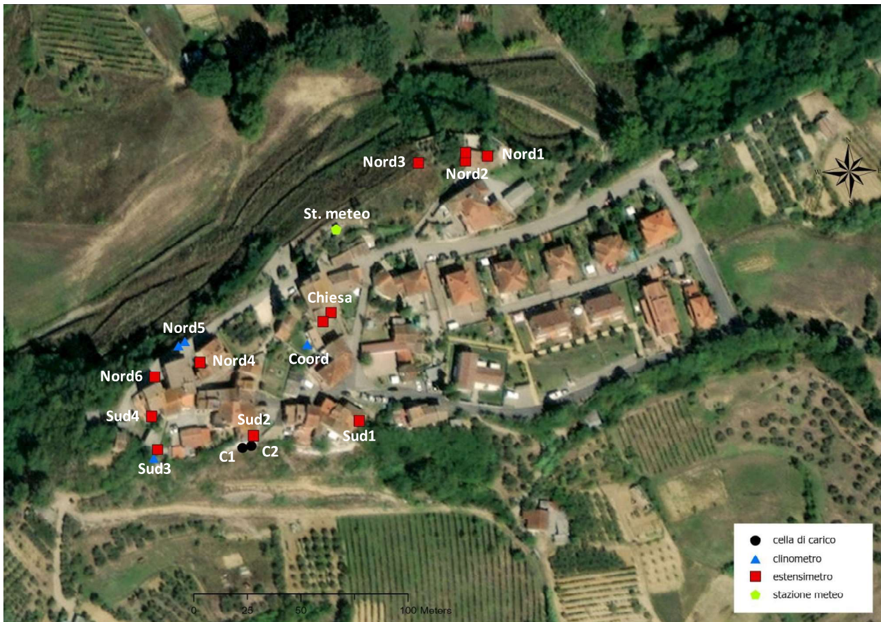
Figura 1 - Ubicazione dei sensori della rete wireless per il controllo delle deformazioni delle strutture. La sigla corrisponde alla denominazione del sensore.
