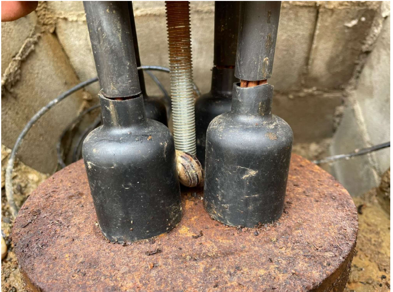
Figura 6 - Immagine della testa del tirante a cui è collegato la cella di carico C2.
