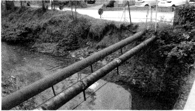
Erosione spondale in destra idraulica
