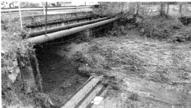
Eccezionale accumulo di materiale solido in sinistra idraulica
